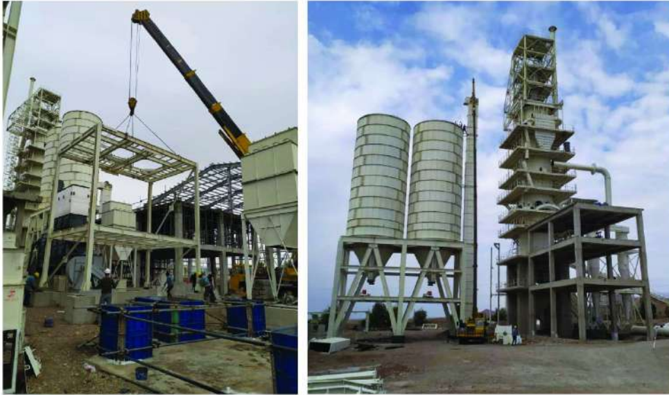
ساخت، نصب و راه اندازی تجهیزات پروژه کربنات کلسیم رسوبی سبزوار
