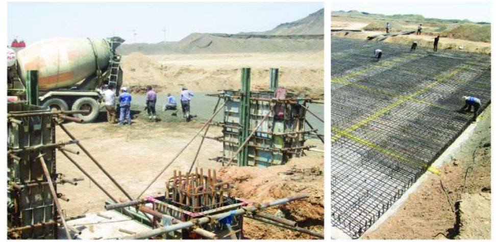
اجرای عملیات ساختمانی (Civil) پروژه کارخانه کنسائتره سنگ آهن اسمالون یزد
