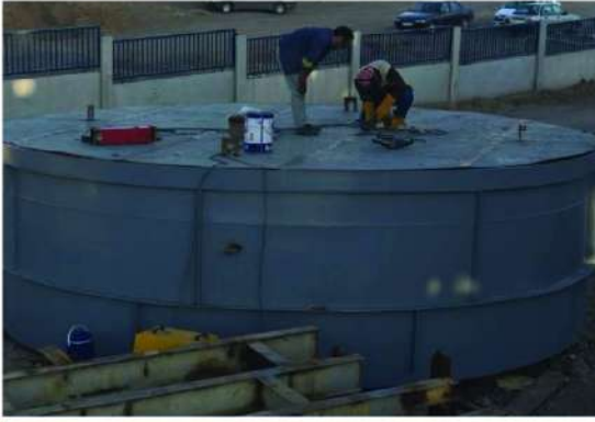
ساخت و نصب مخازن و سیلوهای پروژه آهک اهر (Diluent Tank Storage , Tank Gas Oil)
