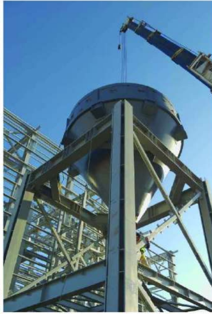
ساخت و نصب مخازن و سیلوهای پروژه آهک اهر (Diluent Tank Storage , Tank Gas Oil)
