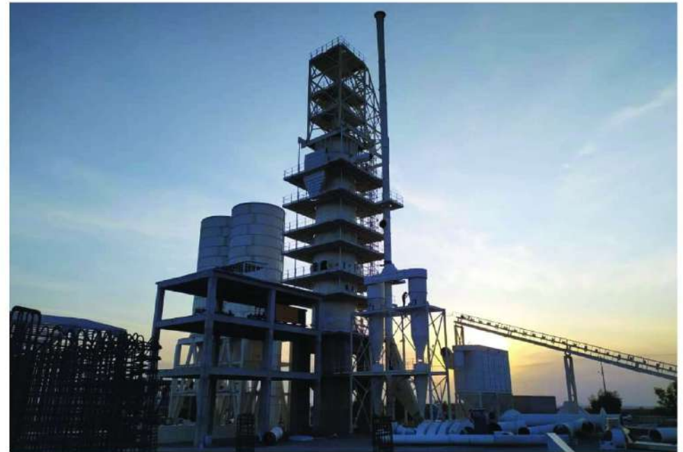
ساخت، نصب و راه اندازی تجهیزات پروژه کربنات کلسیم رسوبی سبزوار
