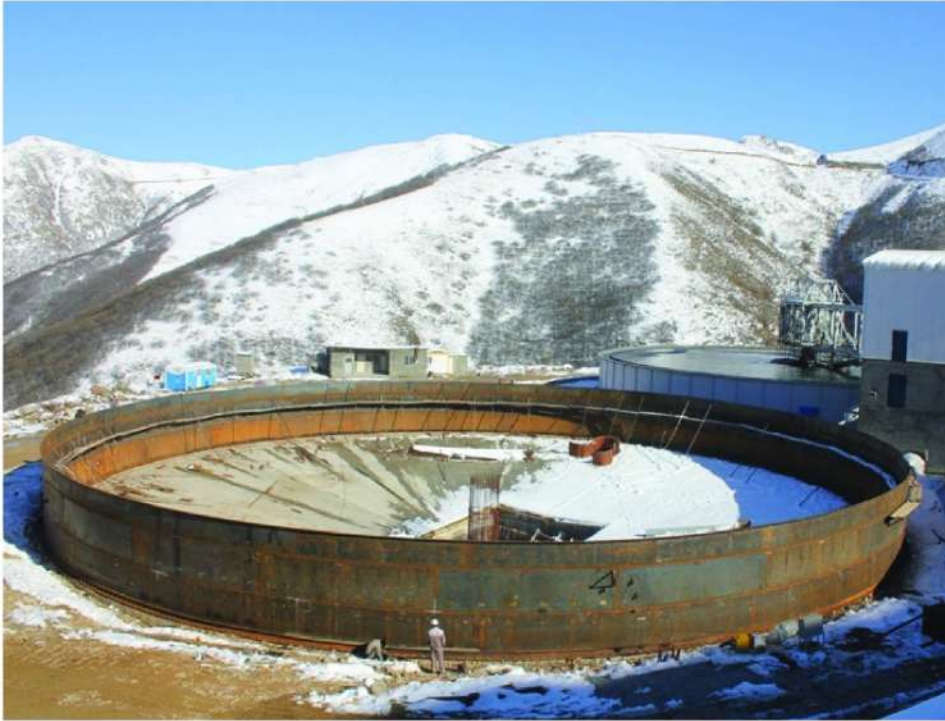
ساخت و نصب مخزن تیکتر باطله به قطر ۴۵ متر - فاز ۲ مس سونگون
