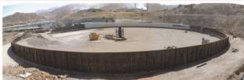
ساخت، نصب و راه اندازی مخزن تیمکتر باطله - به قطر ۱۲ متر به همراه کلیه تجهیزات داخلی
