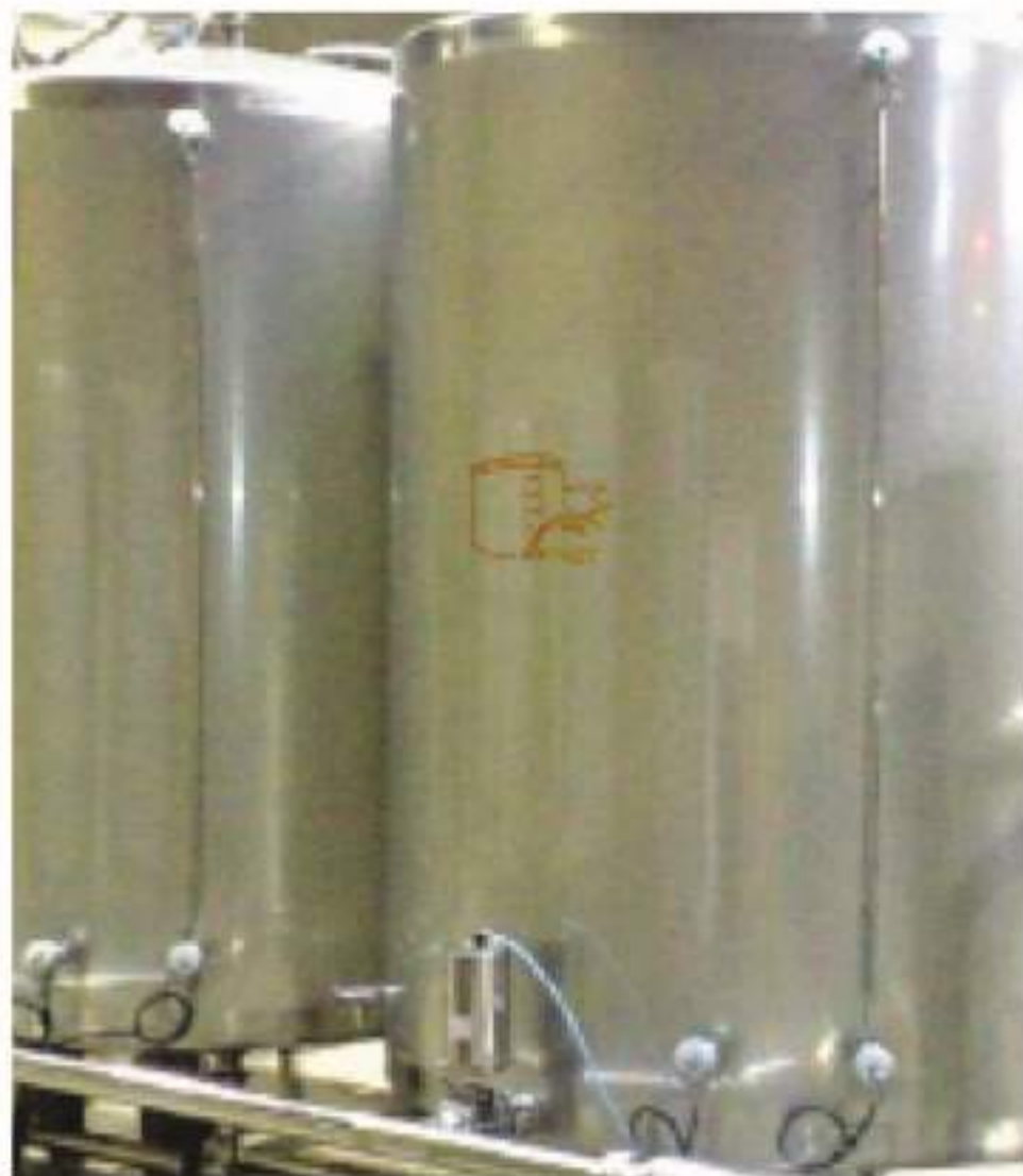
احداث مخازن گازخانه شیرین عمل
