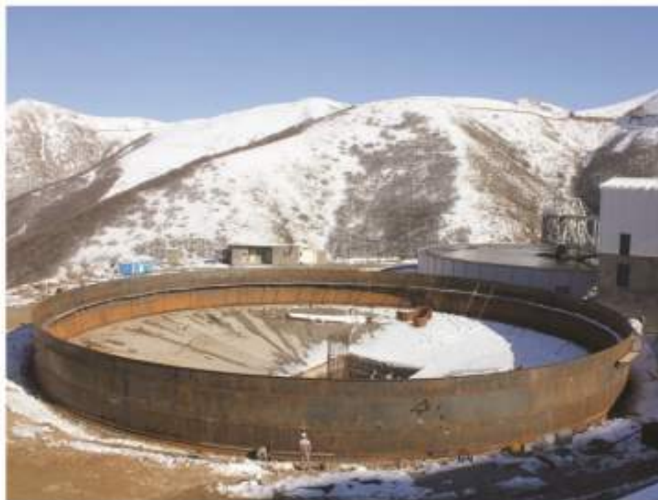
ساخت و نصب مخزن تیمکتر باطله به قطر ۴۵ متر - فاز ۲ - مس سونگون
