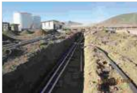
احداث کارخانه هیپ لیچینگ مس نارباغی الکتریکال: کابل کشی و نصب تجهیزات مربوطه
