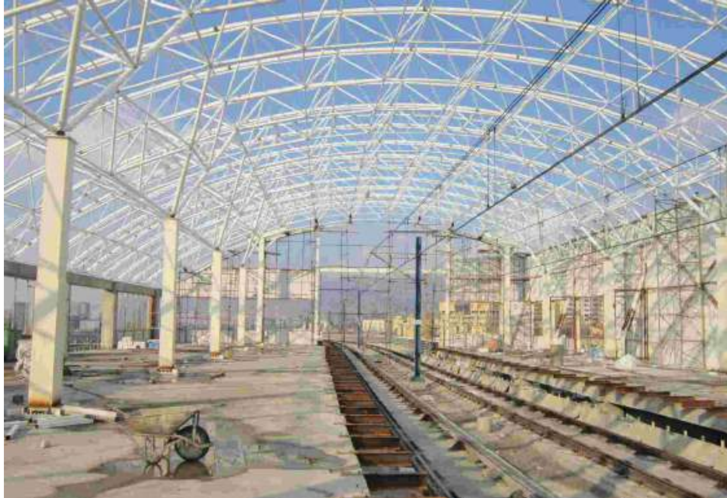
ساخت و نصب سازه فلزی ایستگاه ۵ متروی تبریز
