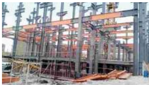
ساخت و نصب سازه فلزي مجتمع كلنيك سلامت تبريز
