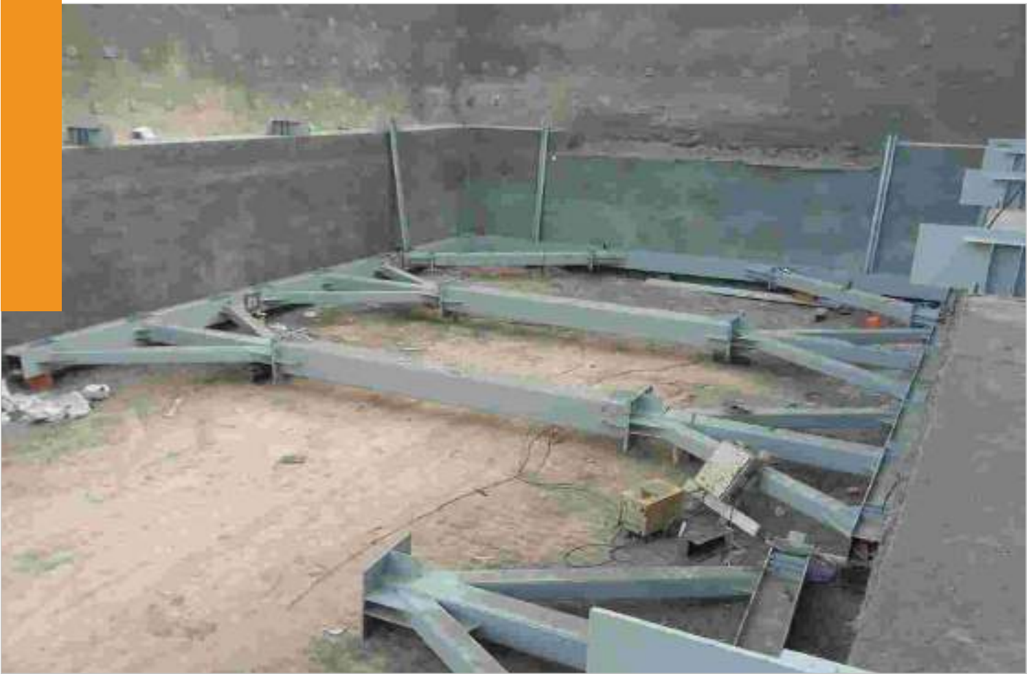
تهیه ، ساخت و نصب استرادهای ایستگاه S۰۲ پروژه خط ۲ قطار شهری
