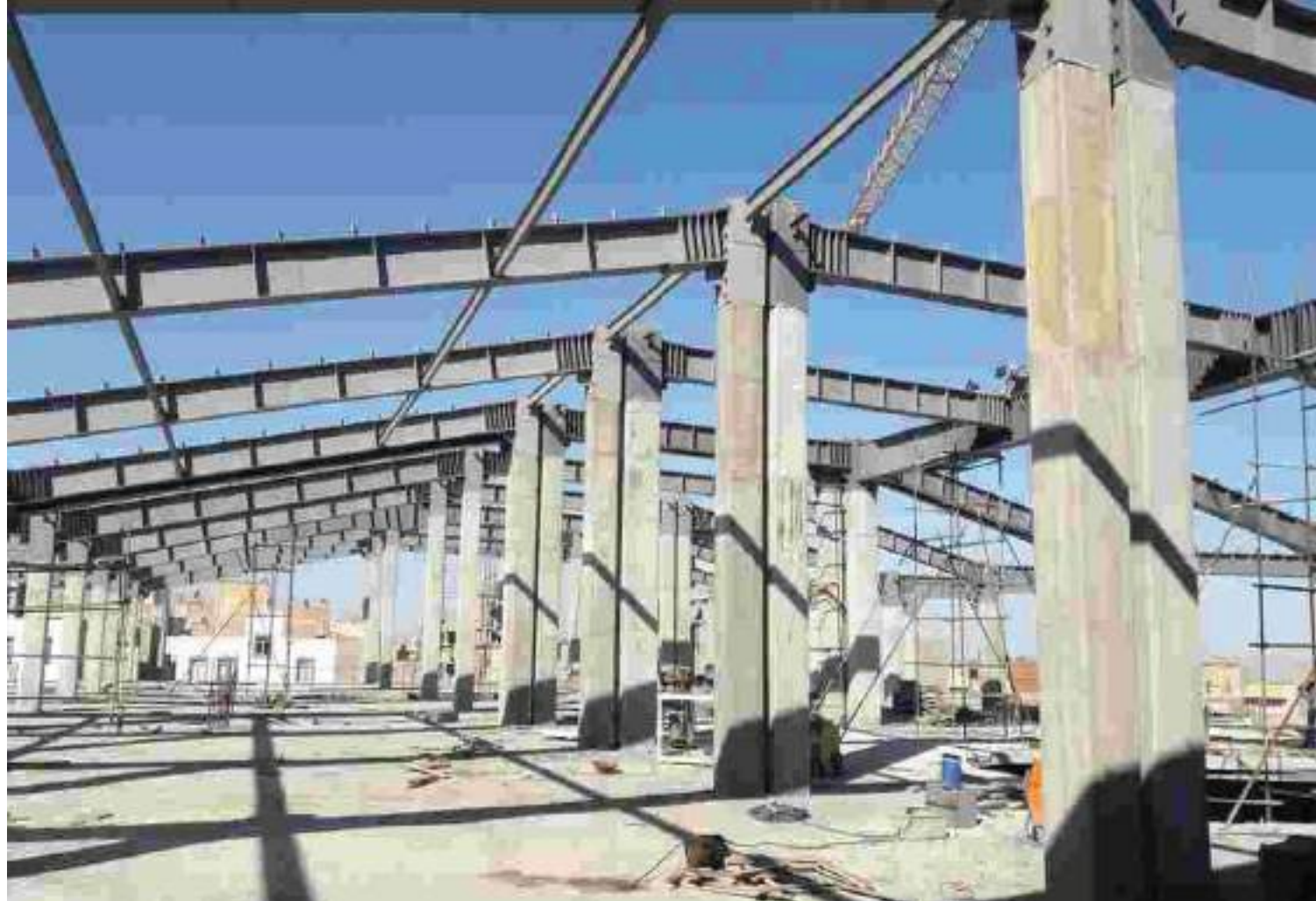
ساخت و نصب سازه فلزی ساختمان خدماتی و تجاری ایپک پالاس
