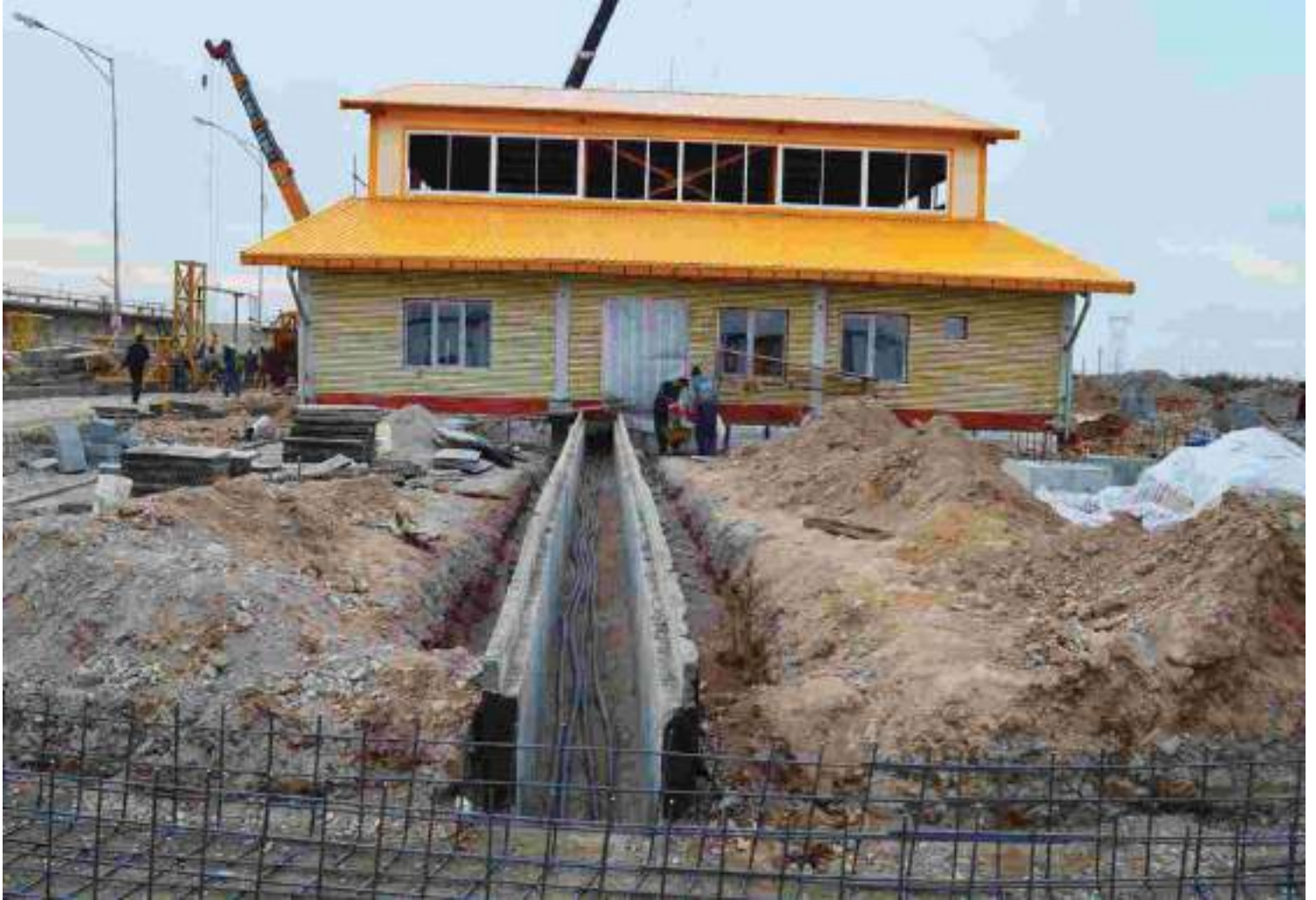
احداث واحد گرانول سازی پالایشگاه تبریز برق و ابزار دقیق : کابل کشی و نصب تجهیزات مربوطه
