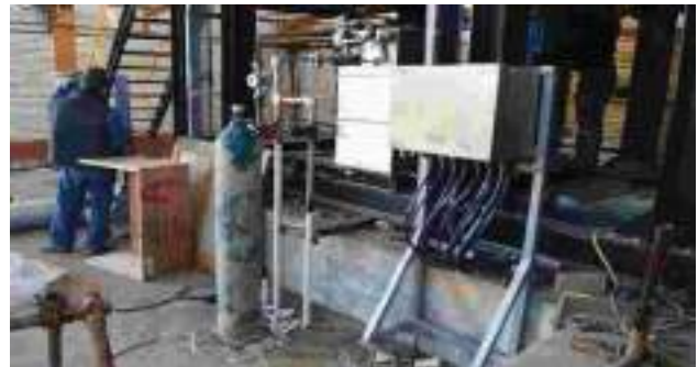
احداث واحد گرانول سازی پالایشگاه تبریز برق و ابزار دقیق : کابل کشی و نصب تجهیزات مربوطه
