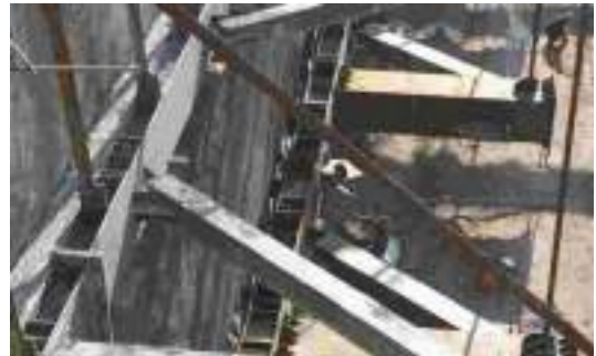
تهیه ، ساخت و نصب استرادهای ایستگاه S۰۲ پروژه خط ۲ قطار شهری
