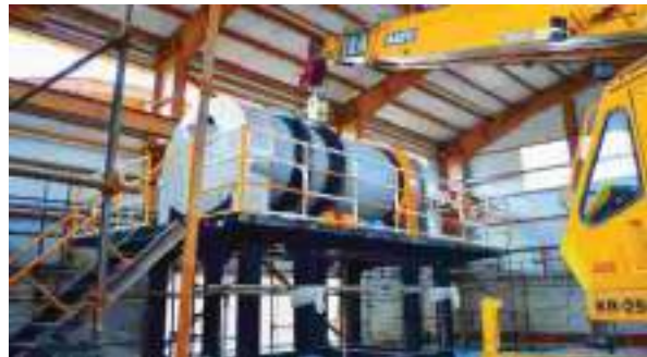
احداث واحد گرانول سازی پالایشگاه تبریز مکانیکی : نصب تجهیزات
