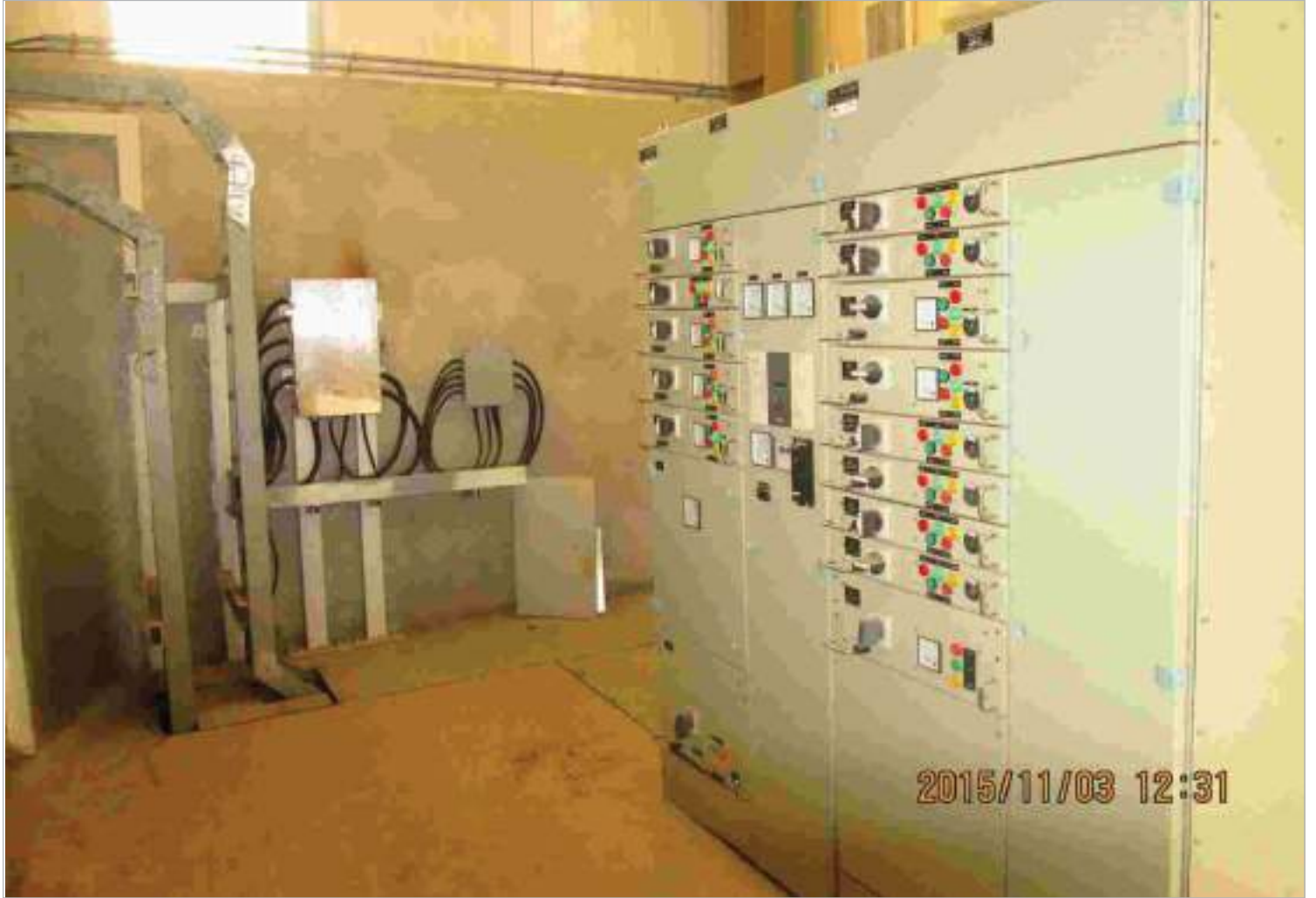
احداث کارخانه هیپ لیچینگ مس نارباغی الکتریکال: کابل کشی و نصب تجهیزات مربوطه
