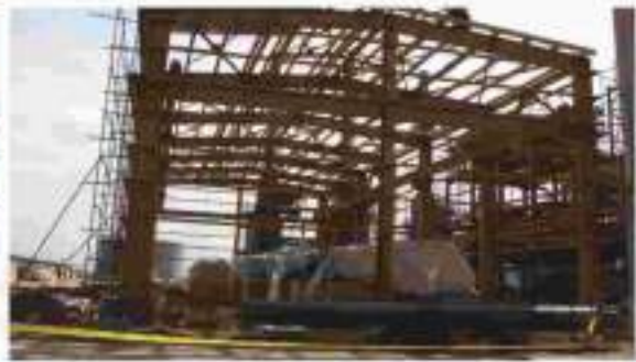
ساخت و نصب سازه فلزی Shelter کمپرسورهای ۵۲۷۰ و ۵۲۵۰
