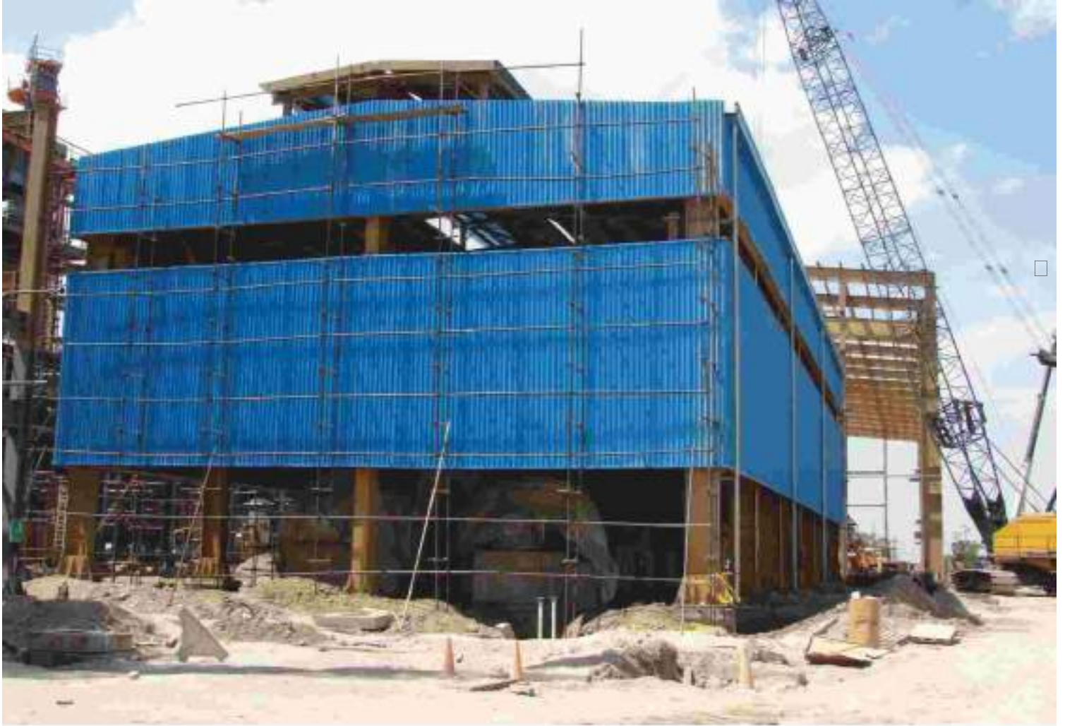
ساخت و نصب سازه فلزی Shelter کمپرسورهای ۵۲۷۰ و ۵۲۵۰
