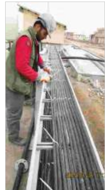
احداث کارخانه هیپ لیچینگ مس نارباغی الکتریکال: کابل کشی و نصب تجهیزات مربوطه
