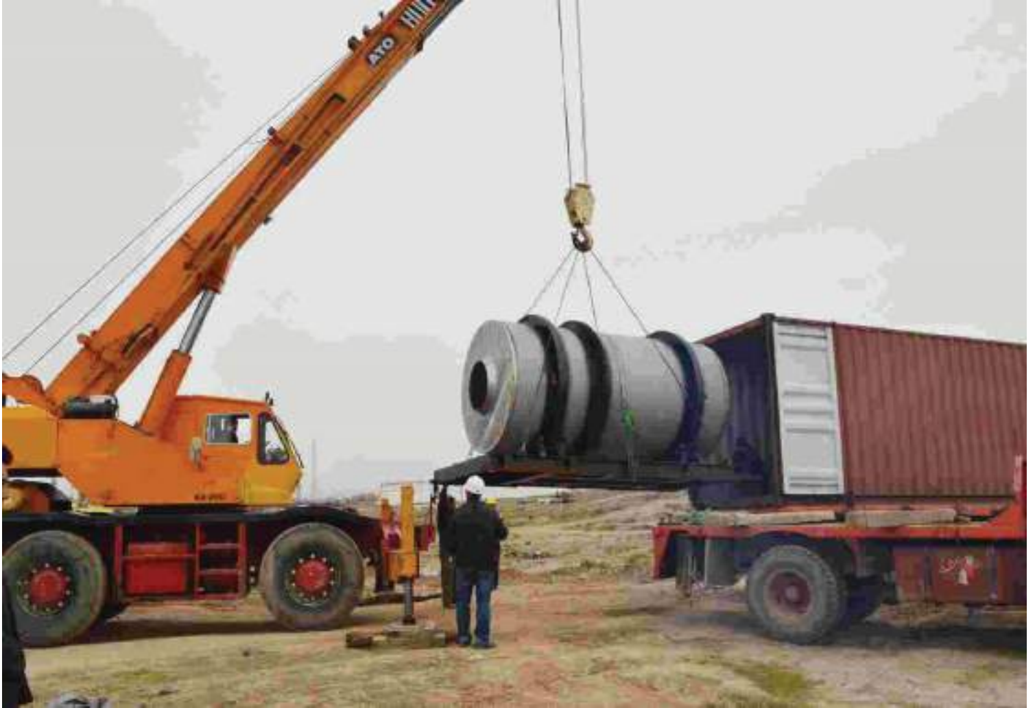
احداث واحد گرانول سازی پالایشگاه تبریز مکانیکی : نصب تجهیزات
